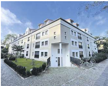
Das Sanierungsprojekt „Rix“.
